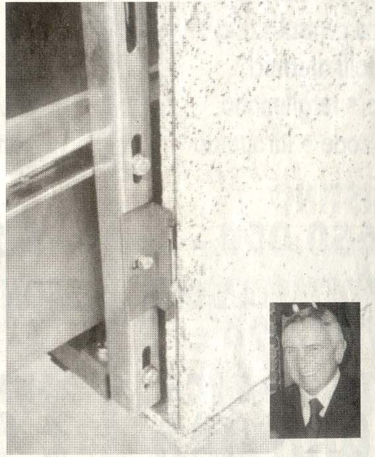
Qui sopra, il palazzo di via Torino appena ultimato. A lato, un particolare di come la pietra viene agganciata alle pareti in modo da lasciare una 'camera d'aria' tra muro e rivestimento. Nel riquadro il geometra Giuseppe Vella titolare della ditta "G. Vella e figlio"
